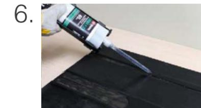
6. Permaflex Reparaturmaterial auftragen
